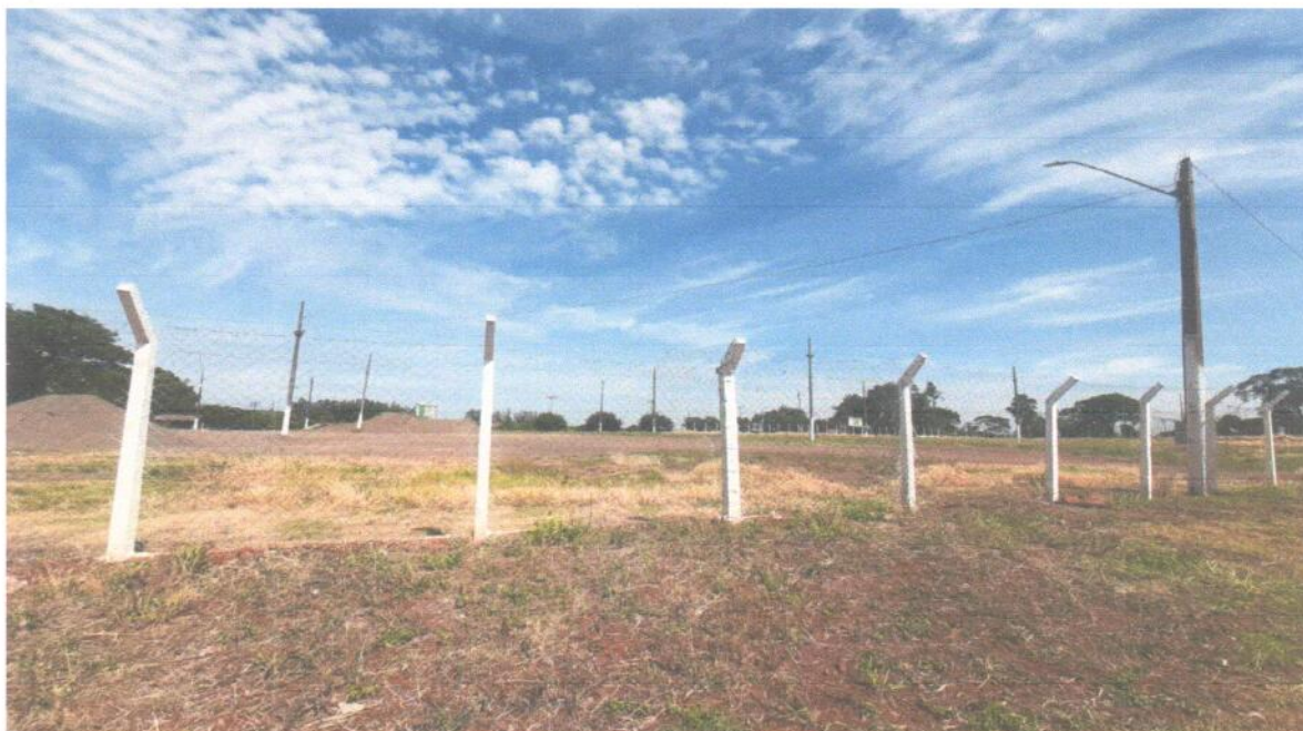
Figura 14: Fachada Esquerda do Im vel.
