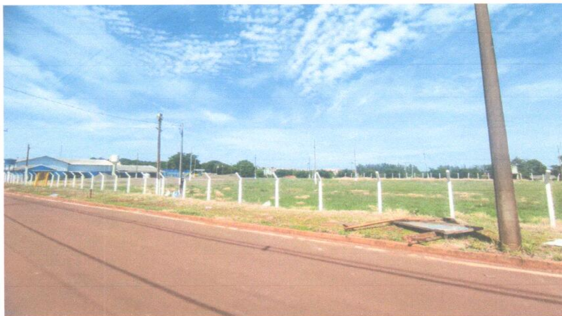
Figura 16: Fachada Direita do Imóvel.
